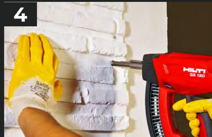
4. Anbringen mit Nägeln ... Assembling by nails ...
