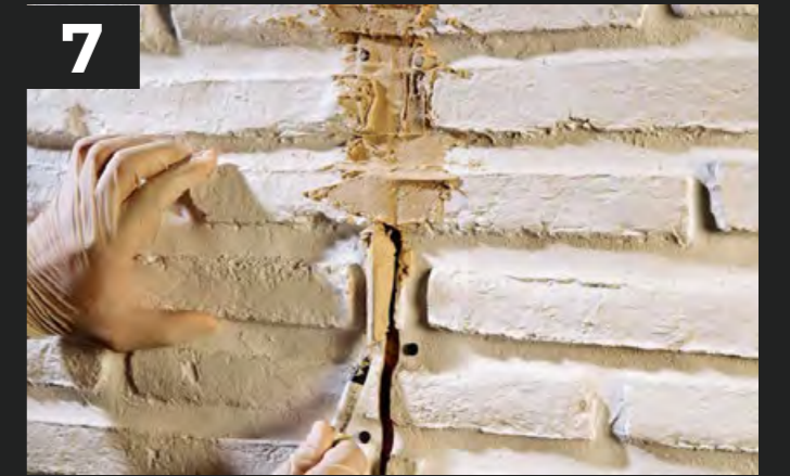
7. Zwischenräume mithilfe eines Spachtelmessers mit Spachtelmasse füllen Covering the spaces by assembly putty by using a putty knife
