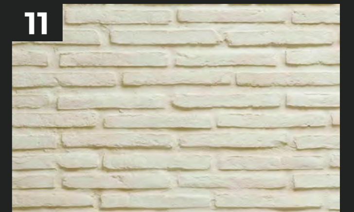
11. Nach dem Trocknen ist die Installation abgeschlossen Installation finished after drying
