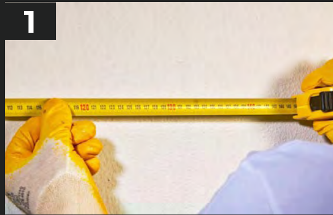
1. Anwendungsbereich ausmessen Measuring the application area
